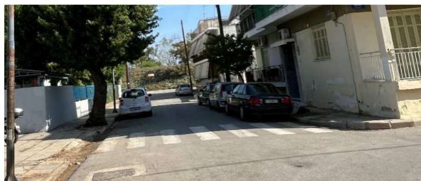
Εικόνα 144: Διάβαση επί της οδού Ανδρέα Καρκαβίτσα με Τσαπραλή (μέτρια κατάσταση) - ξεθωριασμένη διαγράμμιση χωρίς ράμπες εξυπηρέτησης ΑμεΑ
