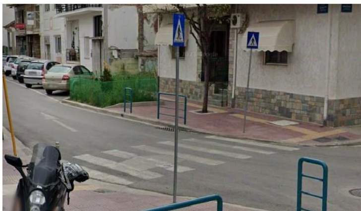
Εικόνα 138: Διαβάσεις επί της οδού Ηρώων Πολυτεχνείου (νότια πλευρά) με Αγίας (μέτρια κατάσταση) - υψομετρική διαφορά ραμπών & ξεθωριασμένη διαγράμμιση
