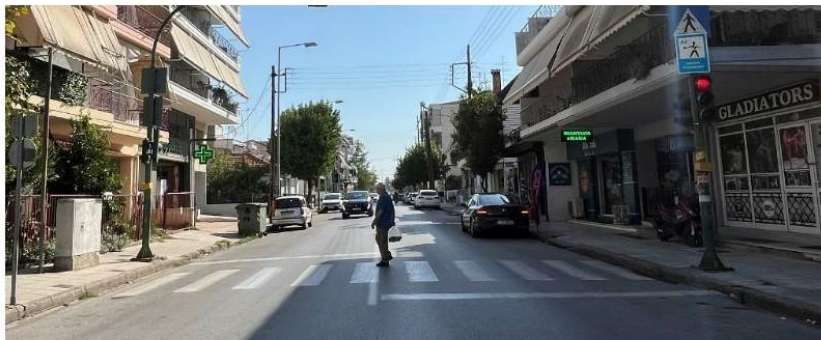
Εικόνα 143: Διάβαση επί της οδού Χατζοπούλου με Ανδρέα Καρκαβίτσα (μέτρια κατάσταση) - ξεθωριασμένη διαγράμμιση χωρίς ράμπες εξυπηρέτησης ΑμεΑ
