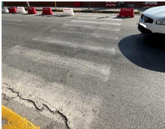
Εικόνα 140: Διάβαση επί της οδού Αγίας (δυτική πλευρά) με Ηρώων Πολυτεχνείου (μέτρια κατάσταση) - υψομετρική διαφορά ραμπών & ξεθωριασμένη διαγράμμιση
