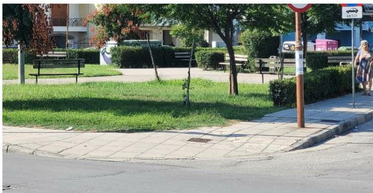
Εικόνα 64: Ράμπα επί της οδού Φαρσάλων (κακή κατάσταση) - υψομετρική διαφορά μεταξύ κρασπέδου της ράμπας και του οδοστρώματος & μεγάλη κλίση ράμπας
