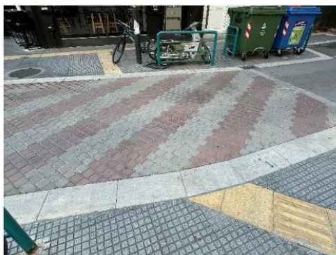
Εικόνα 146: Ράμπα επί της Αγίας με Γεωργίου Σεφέρη (κακή κατάσταση) – χωρίς οδηγό όδευσης τυφλών με μεγάλη κλίση και χωρίς πλάκες πεζοδρομίου
