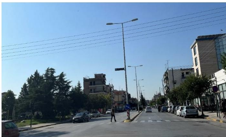
Εικόνα 138: Διαβάσεις επί της οδού Ηρώων Πολυτεχνείου (νότια πλευρά) με Αγίας (μέτρια κατάσταση) - υψομετρική διαφορά ραμπών & ξεθωριασμένη διαγράμμιση
