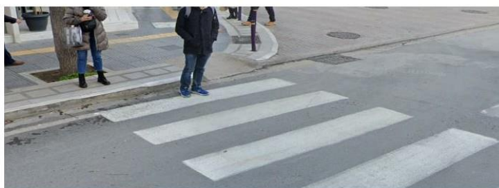
Εικόνα 27: Ράμπα επί της οδού Κύπρου (κακή κατάσταση) - υψομετρική διαφορά μεταξύ κρασπέδου της ράμπας και του οδοστρώματος & μεγάλη κλίση ράμπας
