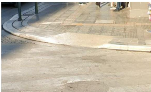
Εικόνα 29: Ράμπες επί της οδού Παπαναστασίου (καλή κατάσταση) - πλήρης προσβασιμότητα
