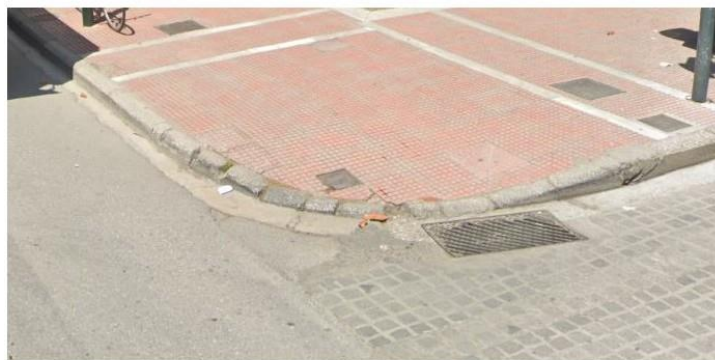
Εικόνα 67: Ράμπα επί της πλατείας ΟΣΕ (μέτρια κατάσταση) - υψομετρική διαφορά μεταξύ κρασπέδου της ράμπας και του οδοστρώματος
