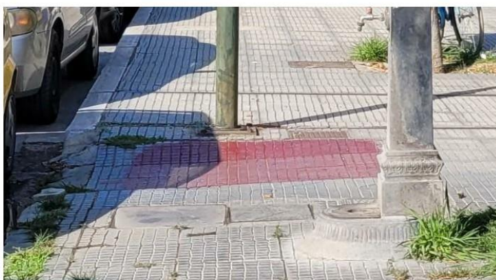
Εικόνα 67: Ράμπα επί της πλατείας ΟΣΕ (μέτρια κατάσταση) - υψομετρική διαφορά μεταξύ κρασπέδου της ράμπας και του οδοστρώματος
