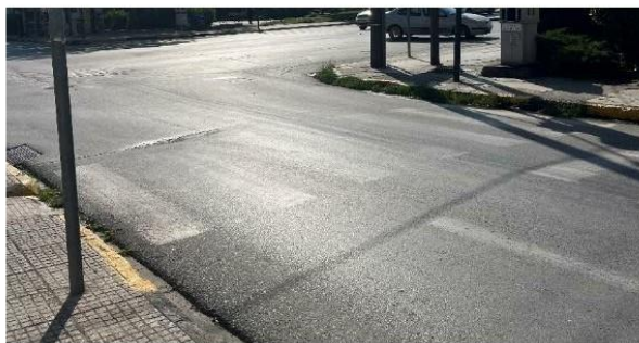
Εικόνα 141: Διάβαση επί της οδού Αγίας (ανατολική πλευρά) με Ηρώων Πολυτεχνείου (μέτρια κατάσταση) - υψομετρική διαφορά ραμπών & ξεθωριασμένη διαγράμμιση
