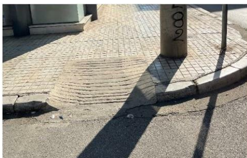
Εικόνα 146: Ράμπα επί της Αγίας με Γεωργίου Σεφέρη (κακή κατάσταση) – χωρίς οδηγό όδευσης τυφλών με μεγάλη κλίση και χωρίς πλάκες πεζοδρομίου
