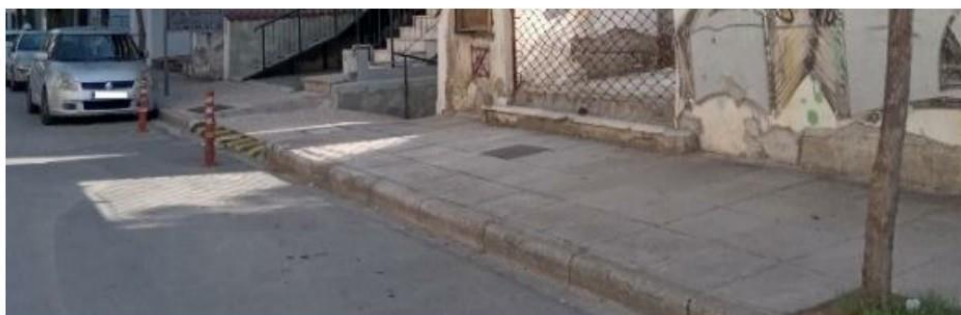
Εικόνα 132: Οδός Γεωργίου Σεφέρη από Νικηταρά έως Αγιάς (ανατολικό τμήμα)
