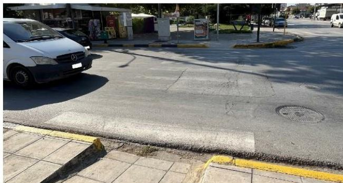
Εικόνα 141: Διάβαση επί της οδού Αγίας (ανατολική πλευρά) με Ηρώων Πολυτεχνείου (μέτρια κατάσταση) - υψομετρική διαφορά ραμπών & ξεθωριασμένη διαγράμμιση
