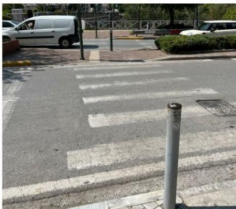
Εικόνα 234: Διάβαση επί της οδού Καλλιθέας (μέτρια κατάσταση) - υψομετρική διαφορά ραμπών & ξεθωριασμένη διαγράμμιση
