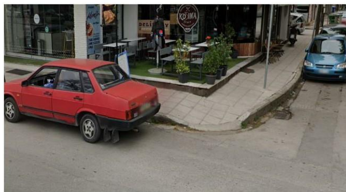
Εικόνα 263: Ράμπα επί της οδού Ηρώων Πολυτεχνείου (μέτρια κατάσταση) - μεγάλη κλίση
