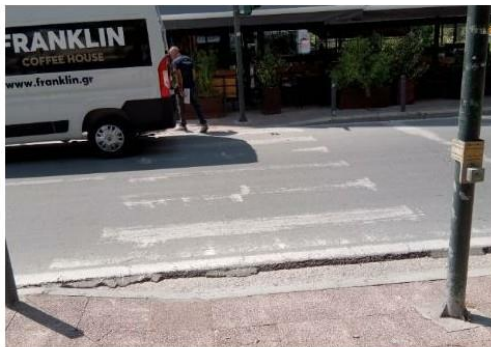
Εικόνα 233: Διάβαση επί της οδού Βενιζέλου στη διασταύρωση με Γεωργιάδου (μέτρια κατάσταση) - ξεθωριασμένη διαγράμμιση
