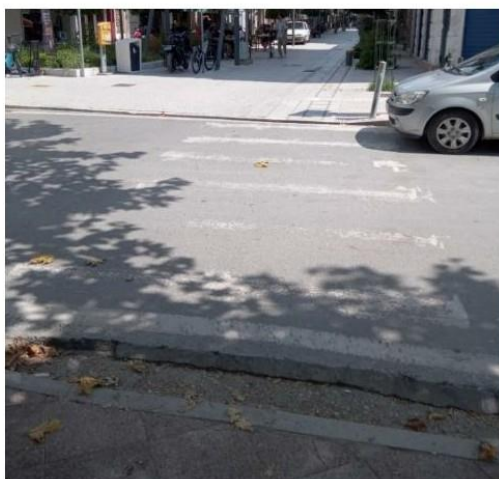
Εικόνα 231: Διάβαση επί της οδού Κενταύρων (κακή κατάσταση) - υπομετρική διαφορά ραμπών & ξεθωριασμένη διαγράμμιση
