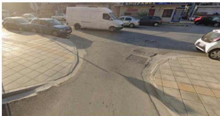
Εικόνα 263: Ράμπα επί της οδού Ηρώων Πολυτεχνείου (μέτρια κατάσταση) - μεγάλη κλίση
