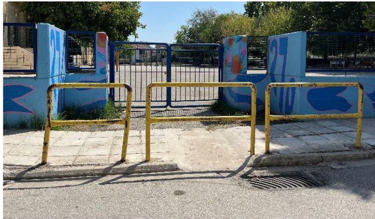
Εικόνα 366: 10 ο Γενικό Λύκειο Λάρισας (είσοδος επί της οδού Ηρακλειανού)
