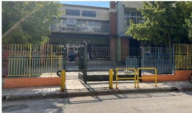
Εικόνα 544: 6 ο Νηπιαγωγείο Λάρισας (είσοδος επί της οδού Θυμάτων Κατοχής)
