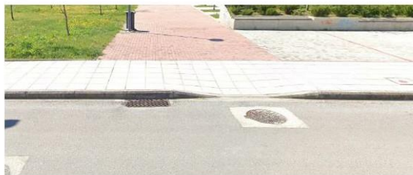
Εικόνα 380: Ράμπα στην οδό Σικελιανού
