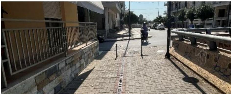
Εικόνα 516: Οδός Εχεκρατίδα (βόρειο τμήμα πεζόδρομος)
