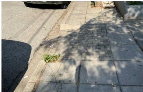
Εικόνα 530: Ράμπα επί της οδού Εχεκρατίδα με την οδό Σαρίμβεη (μέτρια κατάσταση) - υψομετρική διαφορά μεταξύ κρασπέδου της ράμπας
