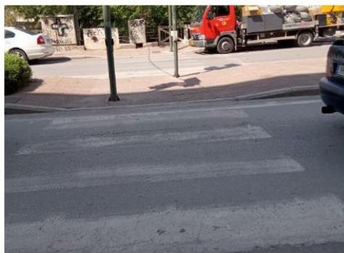
Εικόνα 234: Διάβαση επί της οδού Καλλιθέας (μέτρια κατάσταση) - υψομετρική διαφορά ραμπών & ξεθωριασμένη διαγράμμιση
