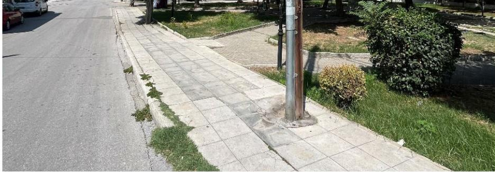
Εικόνα 341: Οδός Δημητρίου Γληνού από Μητροπολίτη Δωροθέου έως Χείρωνος (βόρειο τμήμα)
