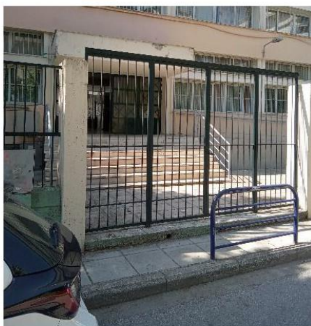
Εικόνα 202: 12 ο Νηπιαγωγείο και 16 ο Νηπιαγωγείο (είσοδος επί της οδού Ρόδου)
