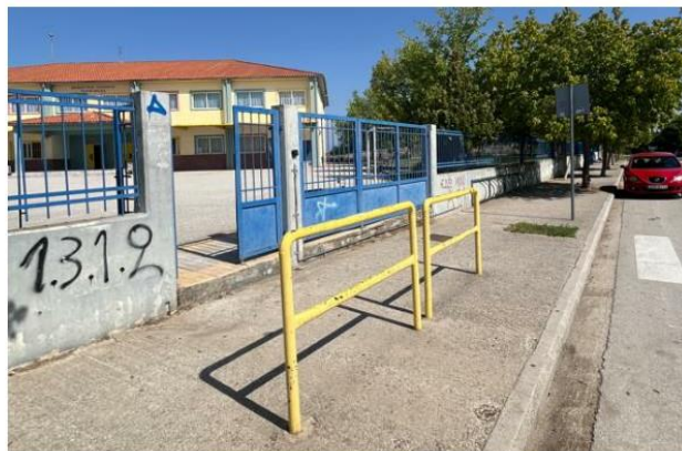
Εικόνα 811: Παιδικός Σταθμός Τερψιθέας
