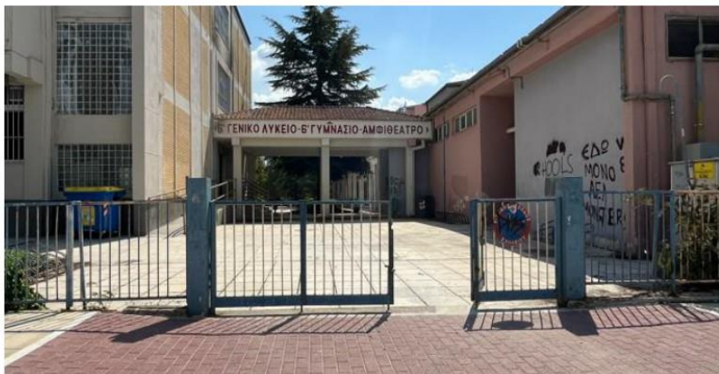
Εικόνα 683: Είσοδος 6 ου Γυμνασίου και Λυκείου επί της οδού 1 ης Μεραρχίας
