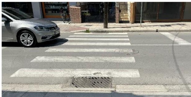
Εικόνα 741: Διάβαση επί της οδού Σωκράτους πλησίον στη διασταύρωση με την οδό Αγαμέμνονος (μέτρια κατάσταση) – έλλειψη ραμπών
