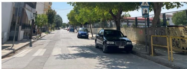
Εικόνα 710: Διαβάσεις επί της οδού Αθ. Λαγού στη διασταύρωσή της με την οδό Ιωαννίνων (κακή κατάσταση) – έλλειψη ραμπών και ξεθωριασμένη διαγράμμιση
