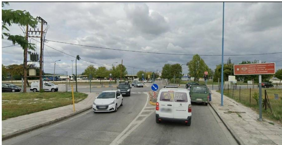
Άποψη οδού Παπανδρέου (ανατολικά του κόμβου)
