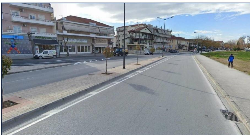
Οδός Σαρίμβειη πλησίον της διασταύρωσης (Πηγή: Google Street View)
