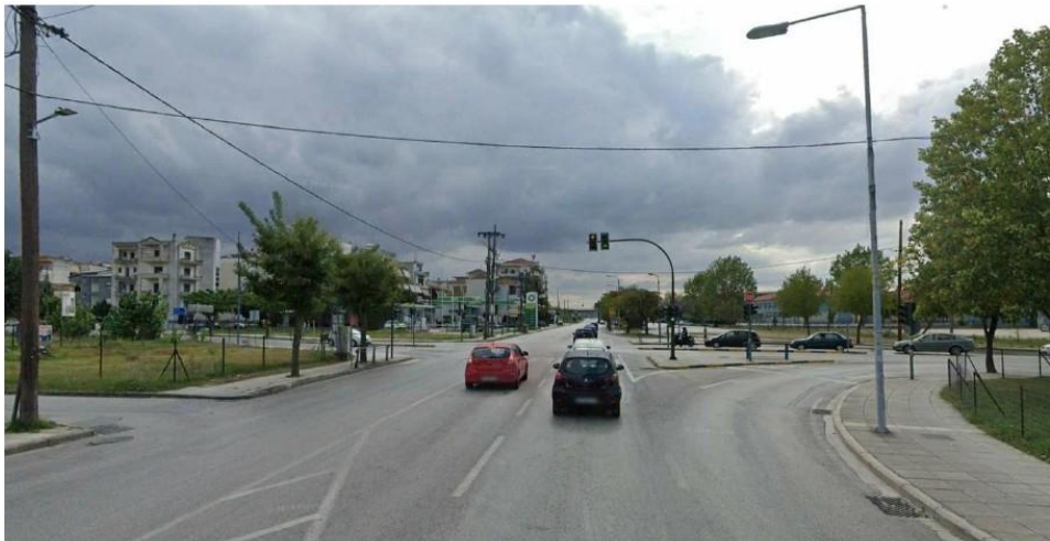
Άποψη οδού Καρδίτσης στο ρεύμα εξόδου από Λάρισα (βόρεια του κόμβου)
