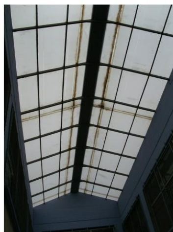
7. Επικάλυψη αιθρίου εσωτερικά
